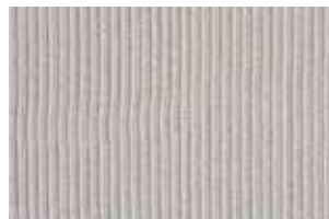
Нанесение зубчатым шпателем
